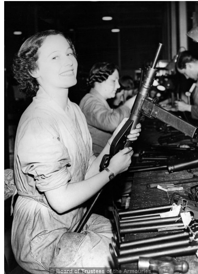
Przewaga obróbki plastycznej – lata 40 XXw. („Pepesza” i STEN)
