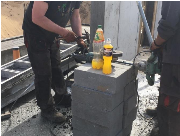
Po skończeniu użytkowania mieszadła, jeden z panów najpierw zdjął czarną masę młotkiem szewskim, a potem doczyścił je mieszając nim żwir z wodą.
