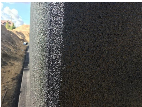
Faktura ścian po nałożeniu masy.
