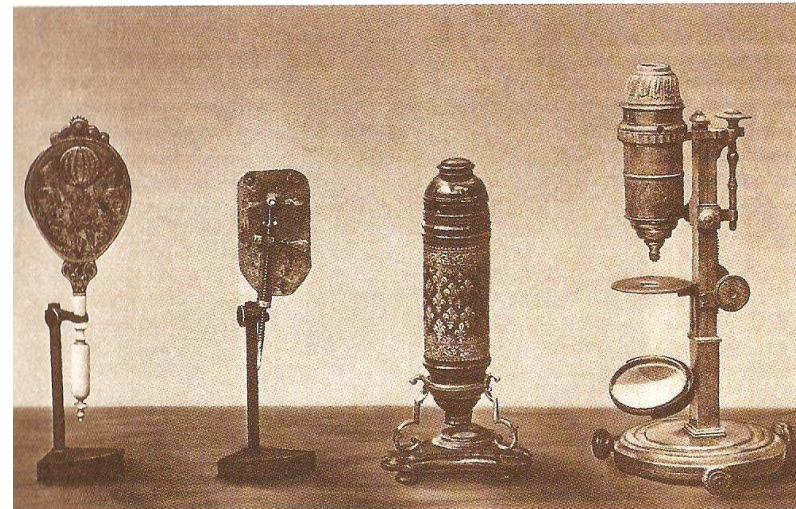
Mikroskopy Antoniego Leeuwenhoeka, który znaczną część tych instrumentów stworzył sam
